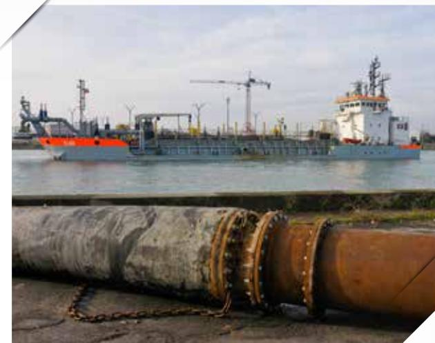
Drague aspiratrice et conduite de refoulement des sédiments de dragage pour les travaux de confortement de la digue des alliés
